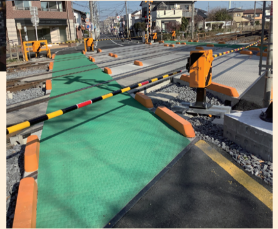
盆栽踏切拡幅完了
