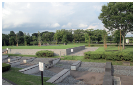
令和元年5月完成
